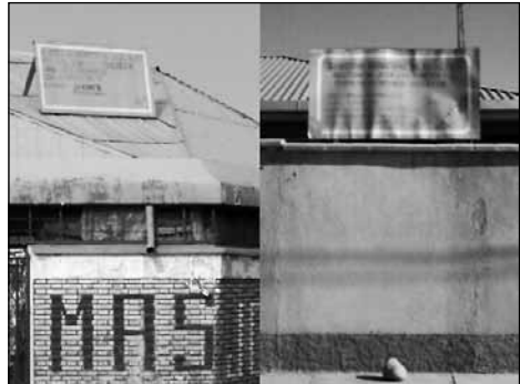
Foto 2. Carteles de metal señalizando obras internas .
