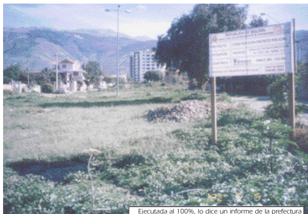
Ejecutada al 100%, lo dice un informe de la prefectura
