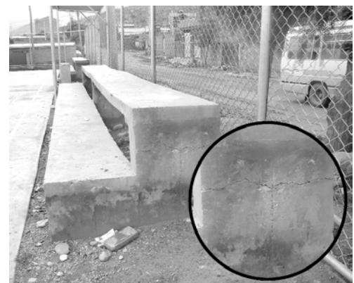
Detalle de la rajadura en esta obra recientemente entregada
