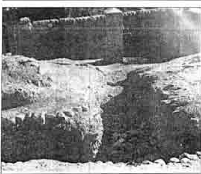
Los huecos ponen en peligro la integridad de los niños.
