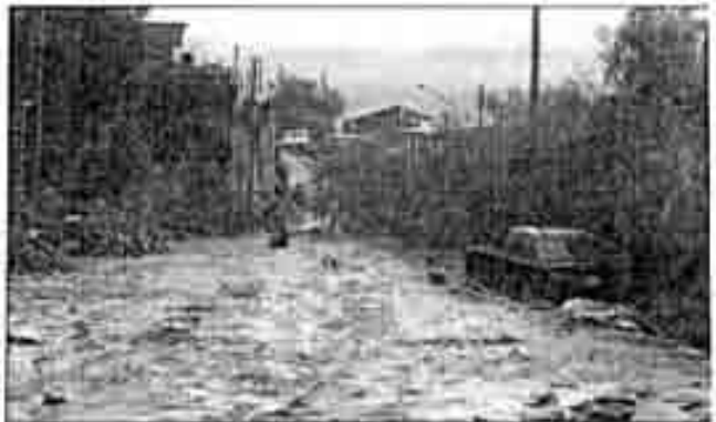
Las lluvias se ensañaron con las calles de la zona.
