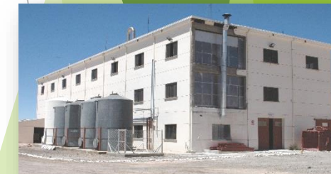
PLANTA PILOTO CARBONATO DE LITIO
