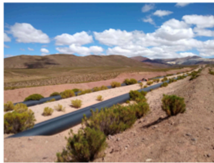
Foto 4.- Tuberías de drenaje de lixiviados de la mina de polimetálicos San Cristóbal
