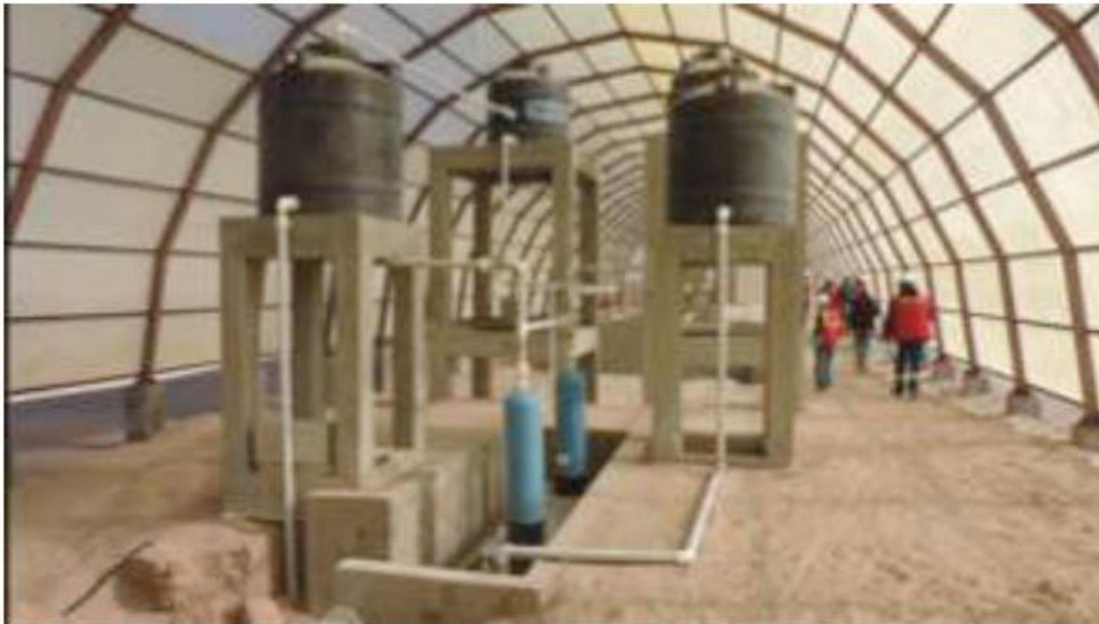
*TANQUES ELEVADOS DE H<sup>2</sup>O PARA ALMACENAMIENTO DE AGUA TRATADA, PARA ALMACENAMIENTO DE REGENERANTES, INFRAESTRUCTURA PARA DESIONIZADORES (+) Y (-) Y DESIONIZADORES.*
