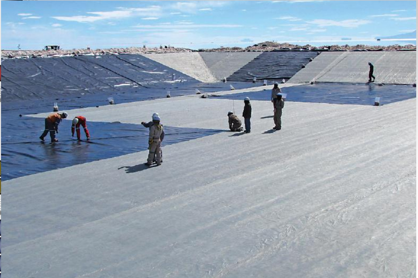
Impermeabilización de piscinas de evaporación
