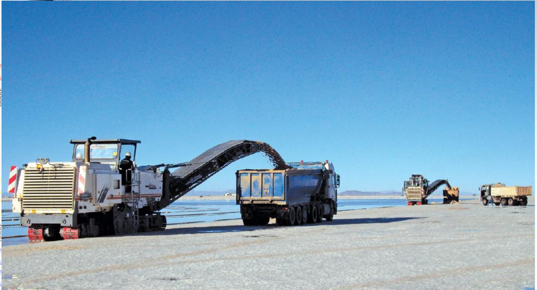
Fresado de sal para diques y terraplenes
