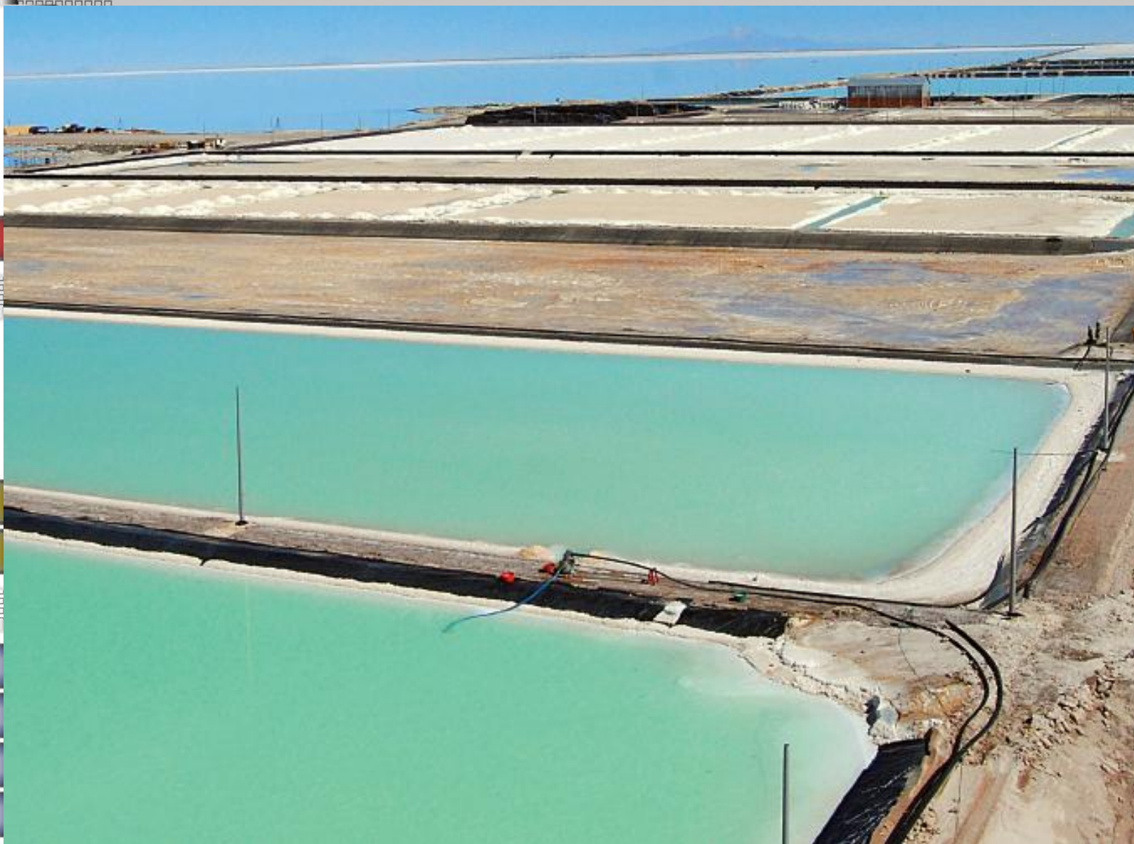
Piscinas de evaporación módulo piloto
