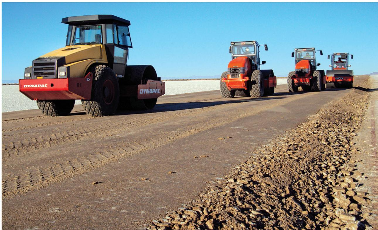
*Compactado de plataforma para la construcción de piscinas de Evaporación*
