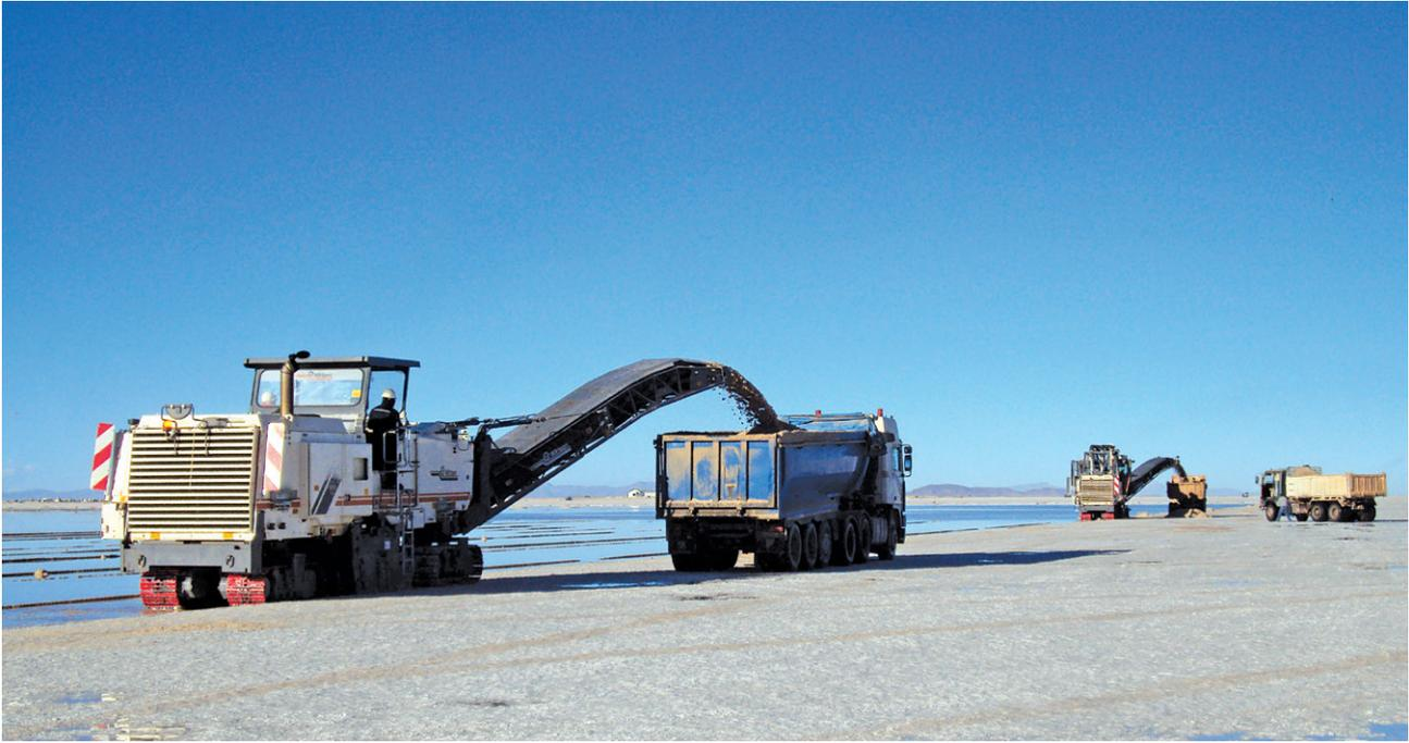
*Trabajo de fresado de sal para la construcción de piscinas de evaporación*
