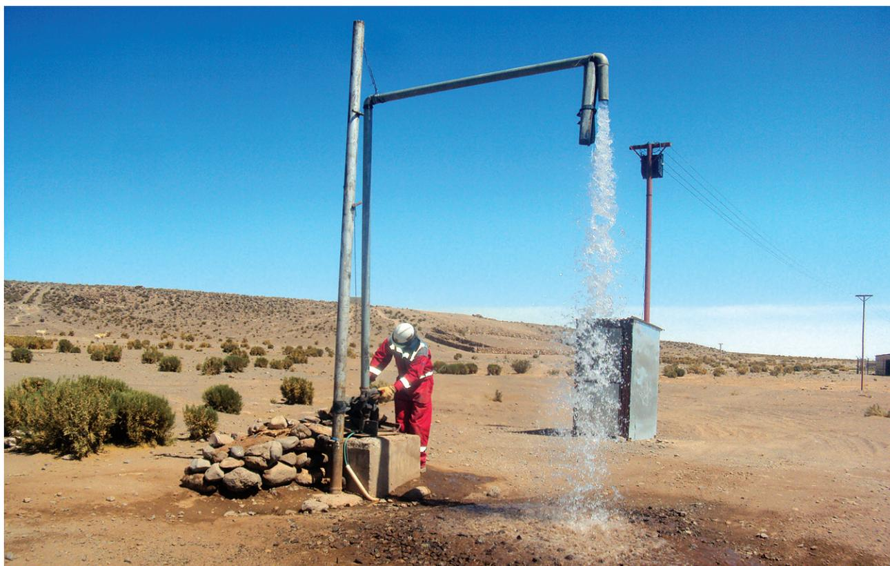
*Captación de agua mediante perforación de pozo realizado por la GNRE en San Gerónimo*
