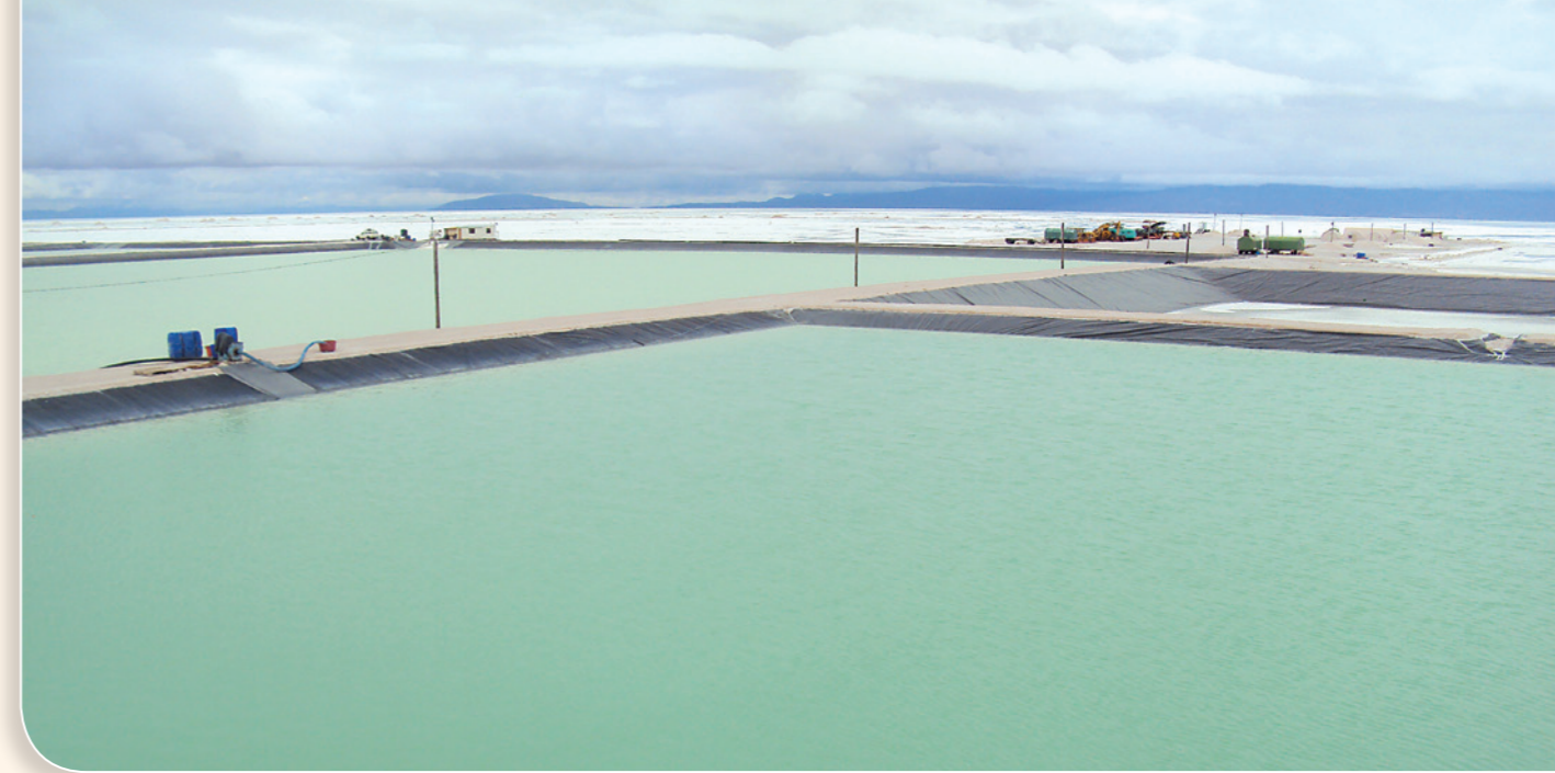
Piscinas de evaporación
