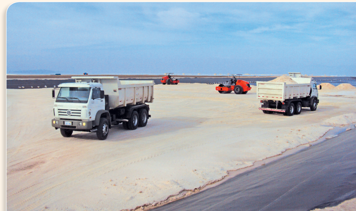
Preparación de piscinas de evaporación correspondiente a la fase industrial
