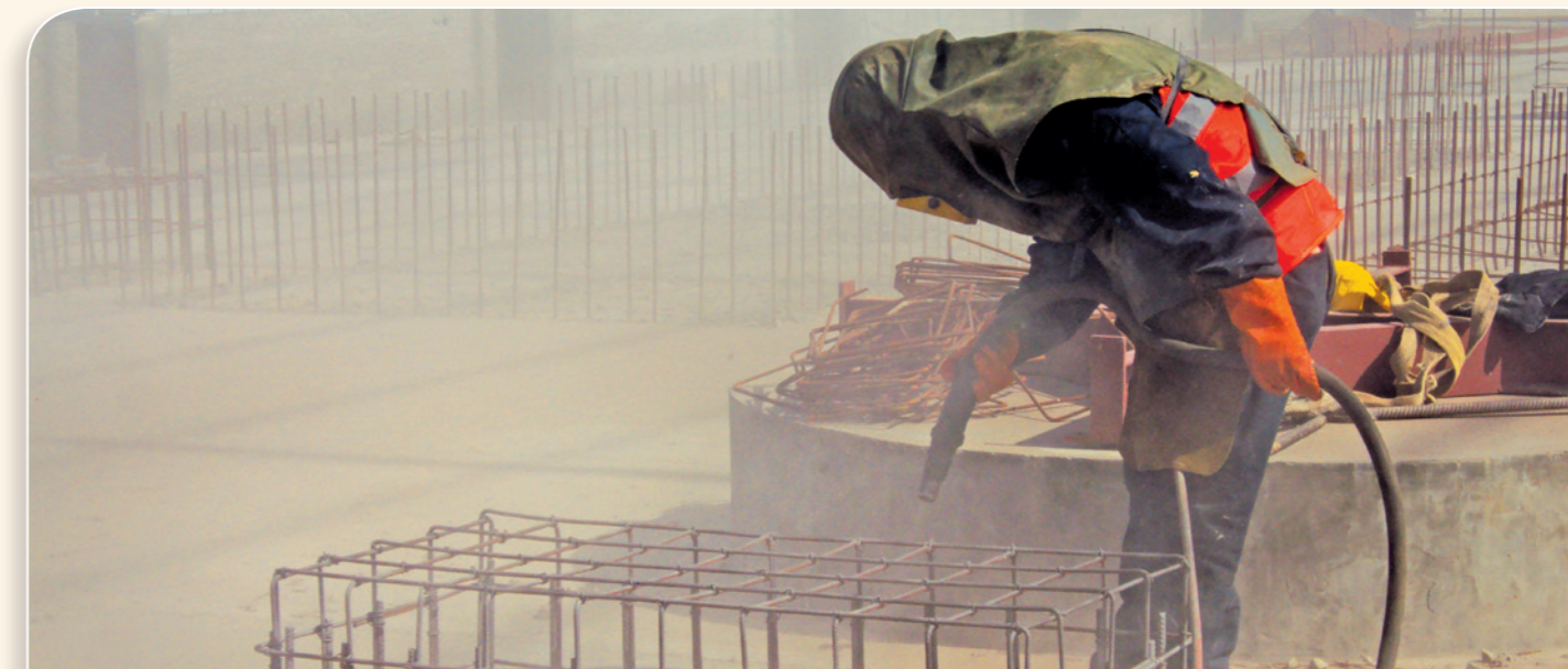
Trabajos en la losa radier
