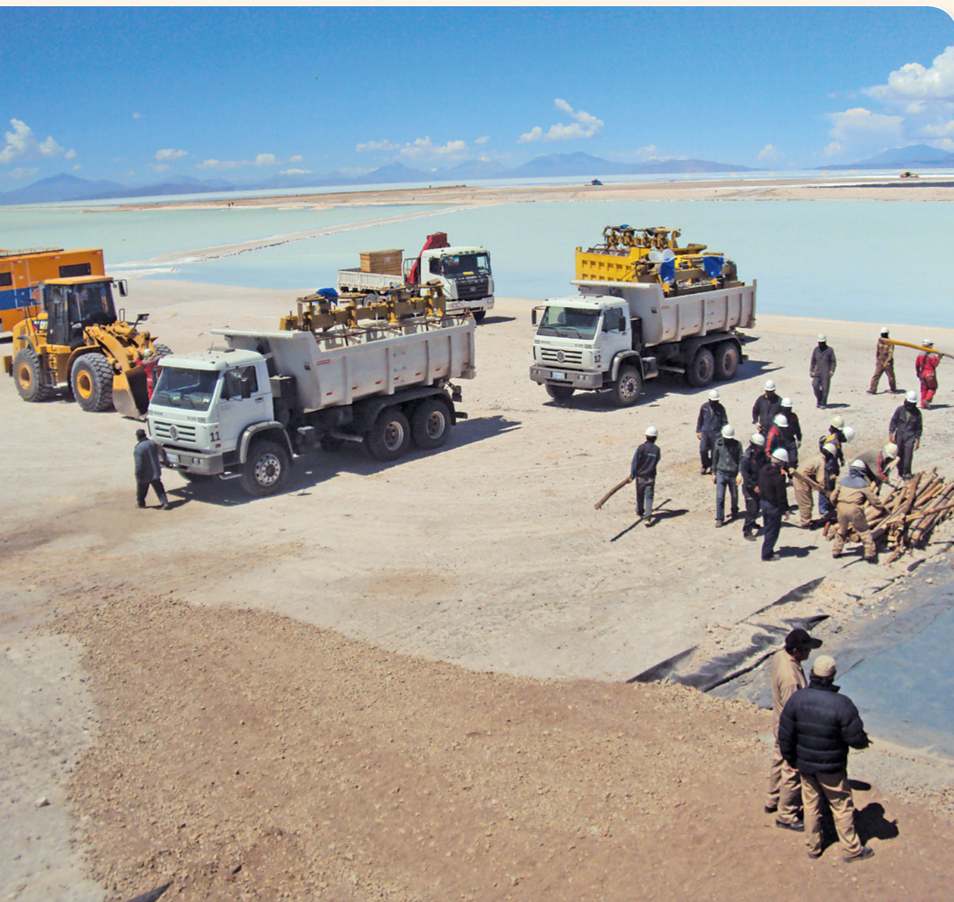
Llegada de equipos para montaje de la Planta de KCl
