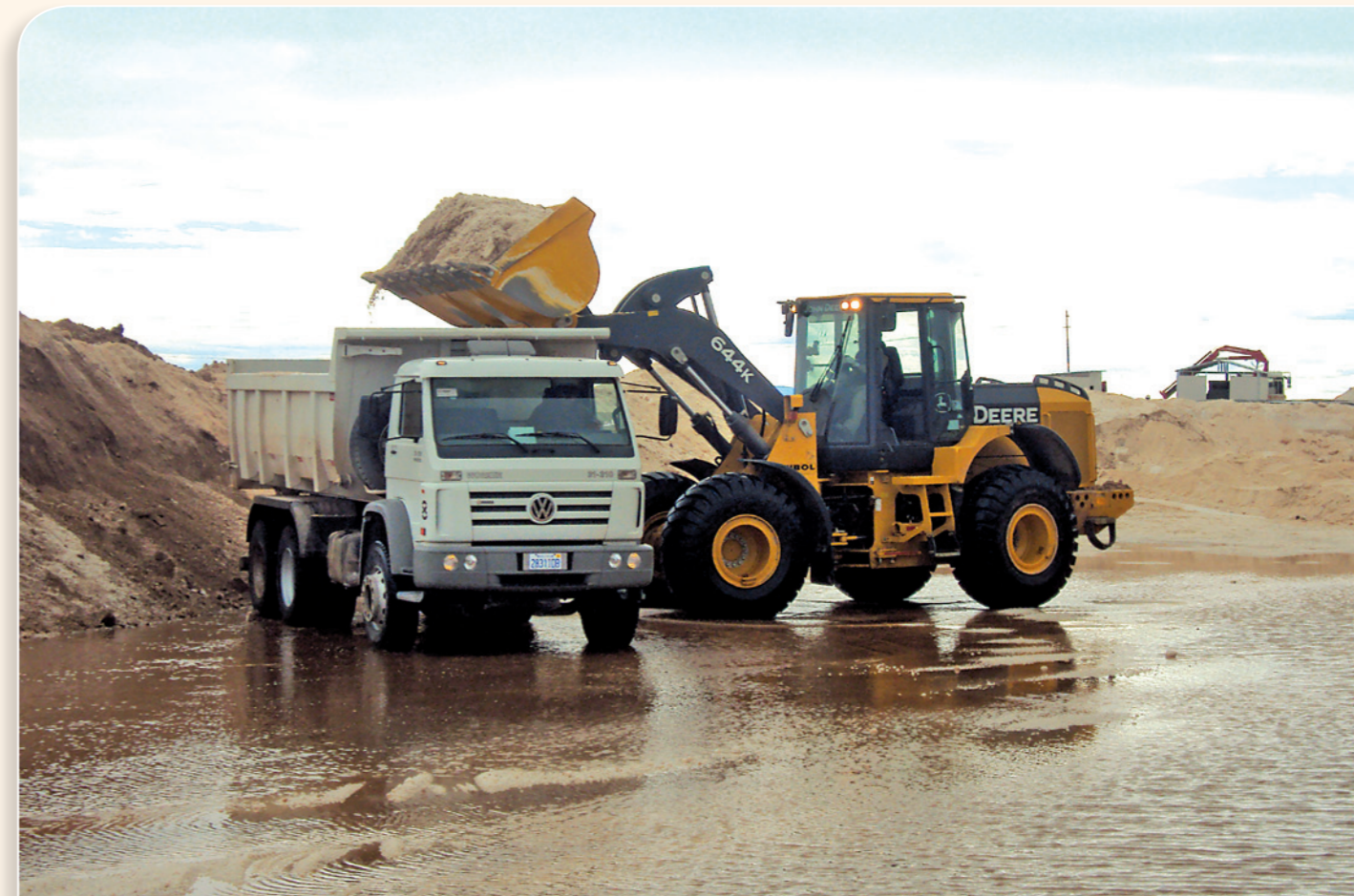
Carguo de sales para construcción de diques
