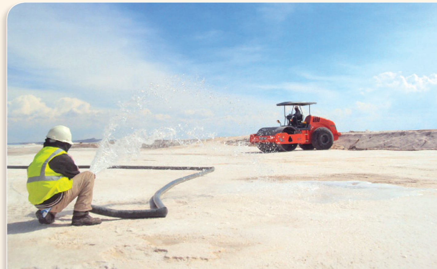
Compactado de plataforma de acoplamiento
