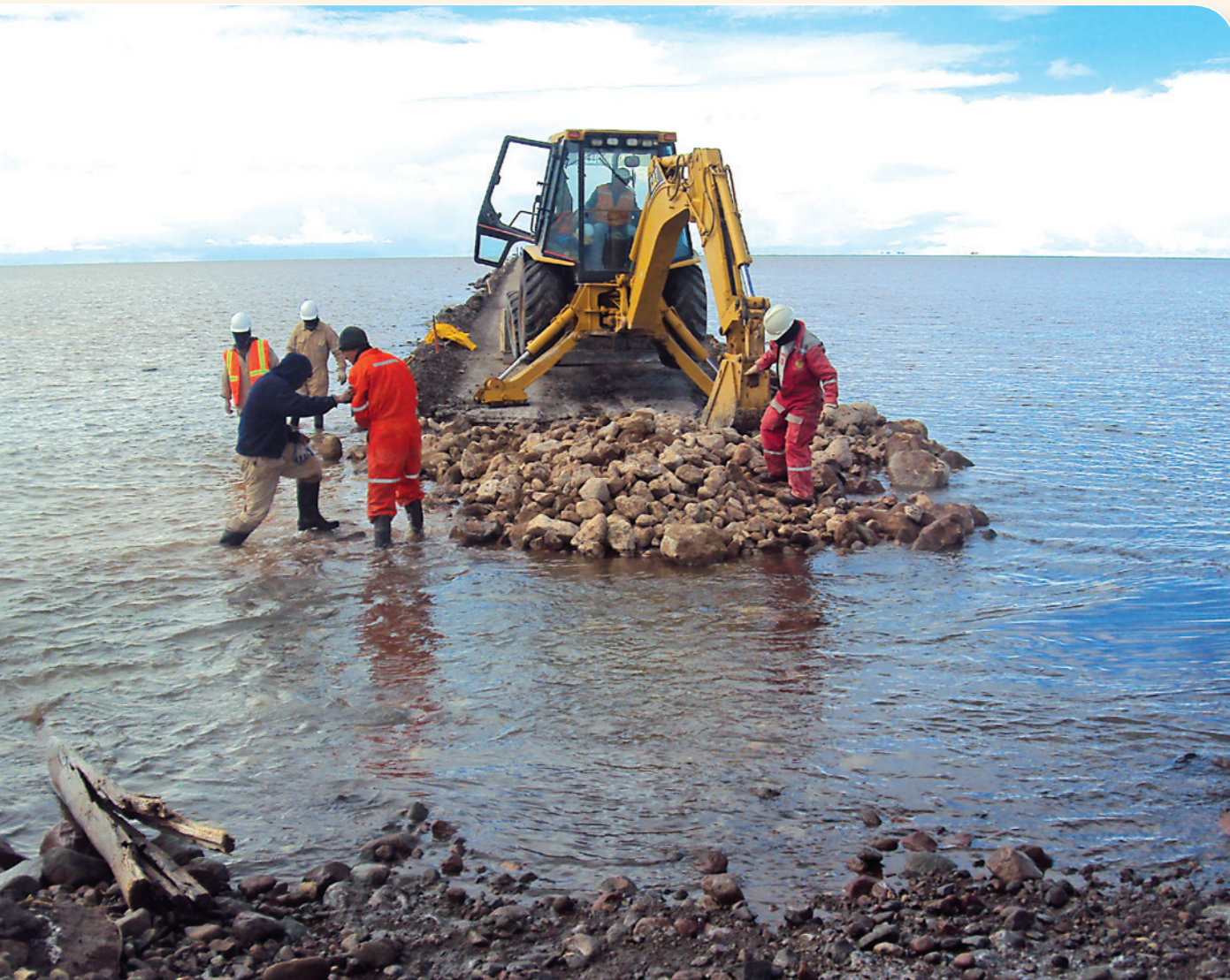
Trabajos en terraplén afectado por inundación
