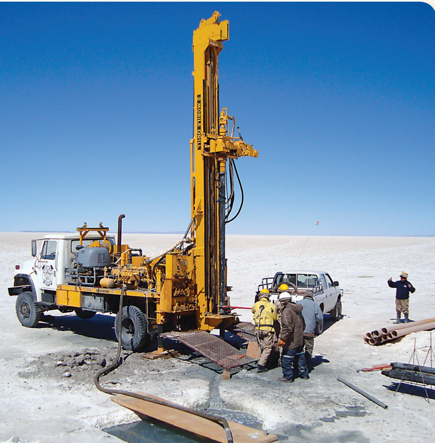
Equipo de perforación
