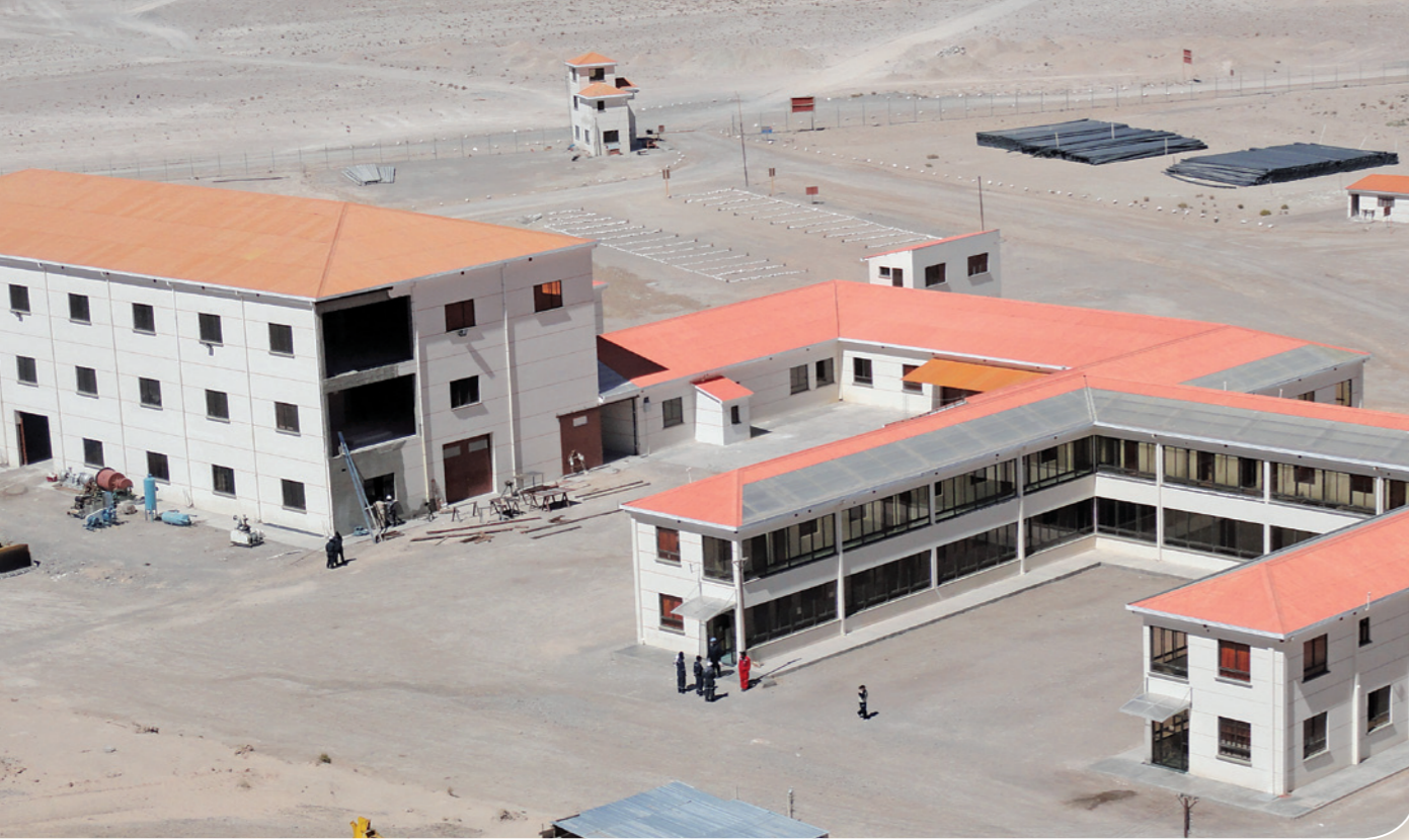
Instalaciones de la Planta de Llipi
