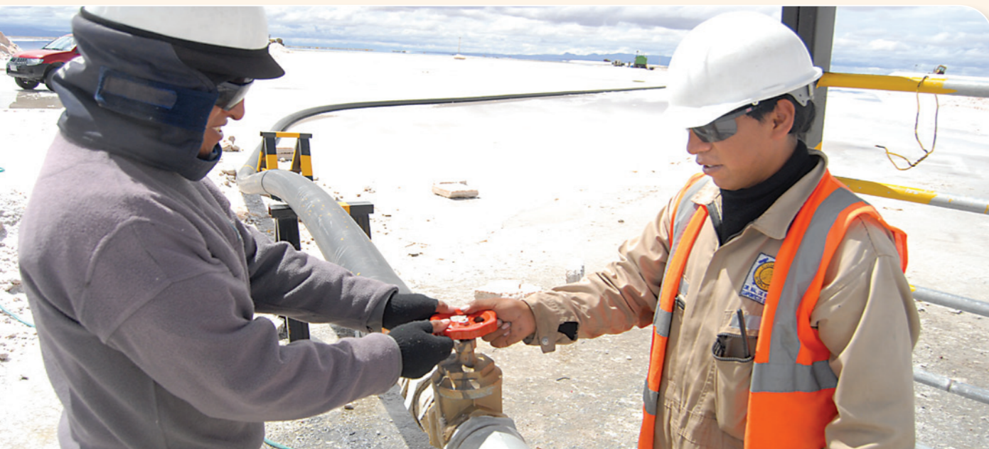
Operación de válvula de Salmueroducto
