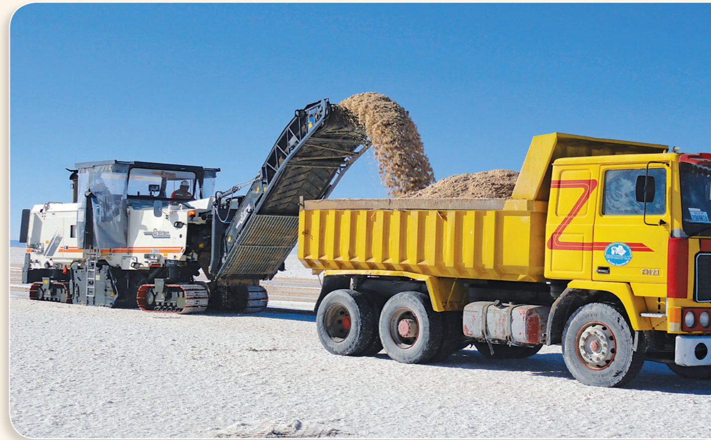
Escarificado y carguo de sal
