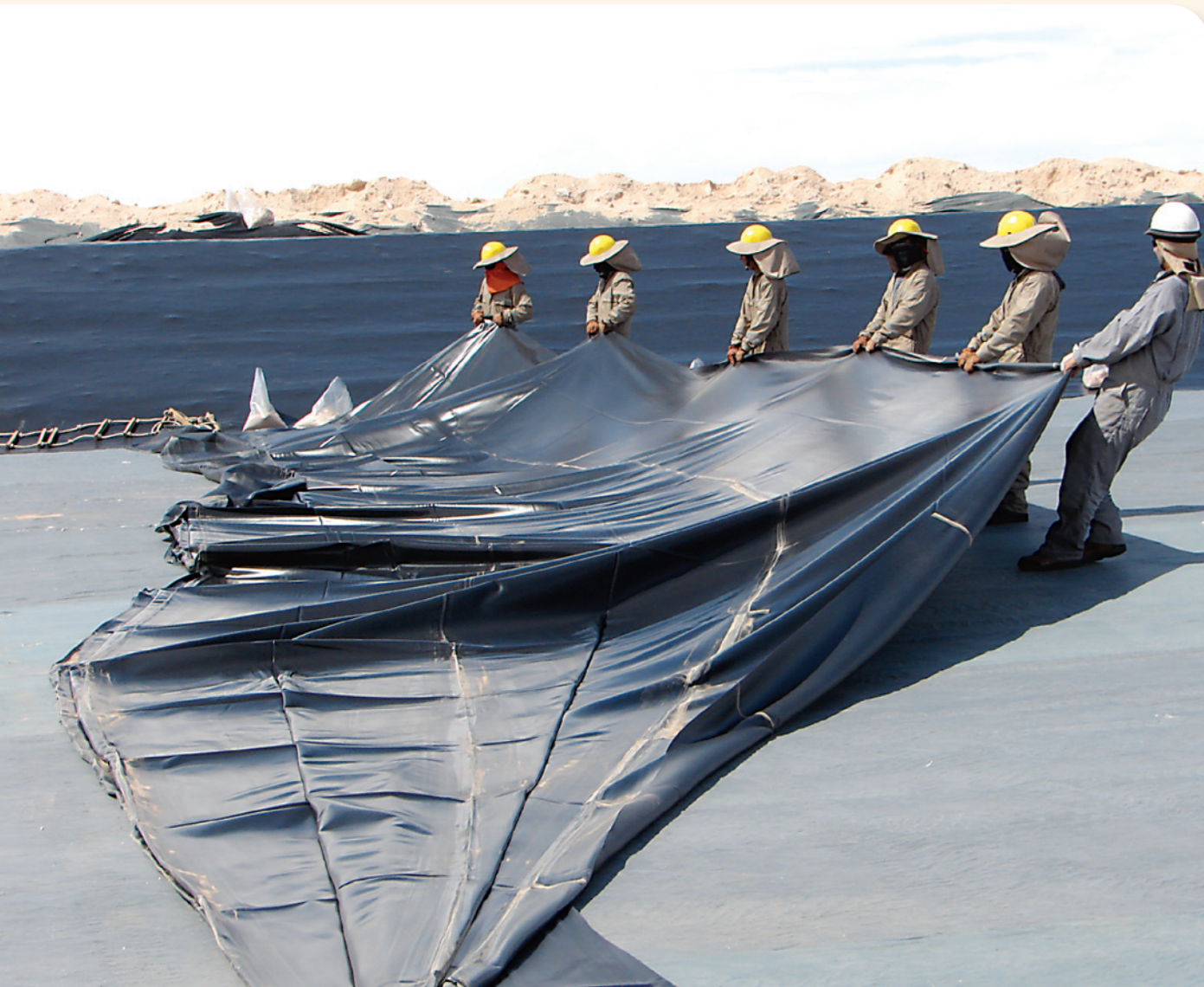
Impermeabilización de piscinas
