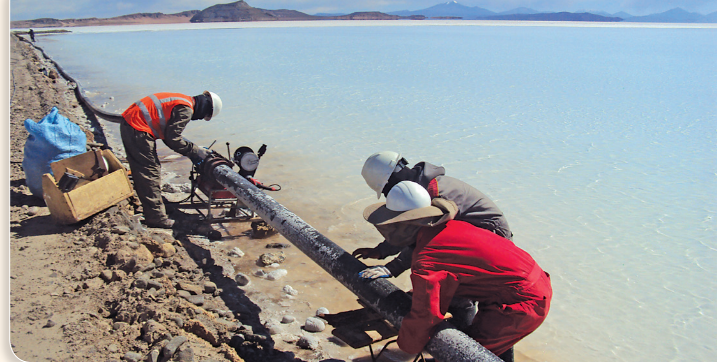
Conexión de tubería para agua potable
