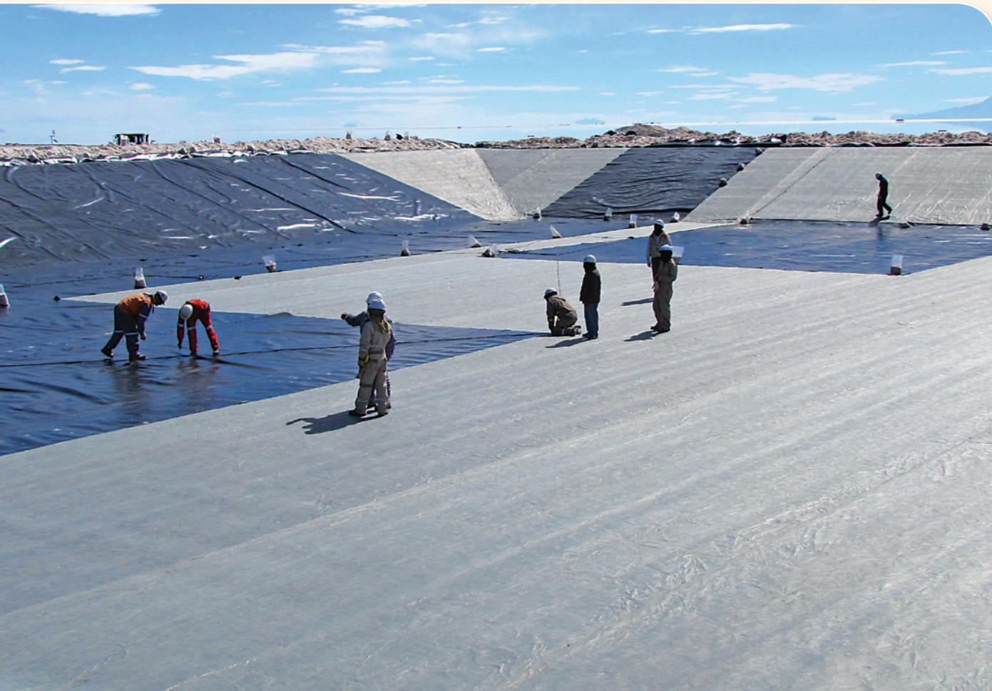
Personal de la GNRE. en trabajos de impermeabilización de las piscinas de evaporación
