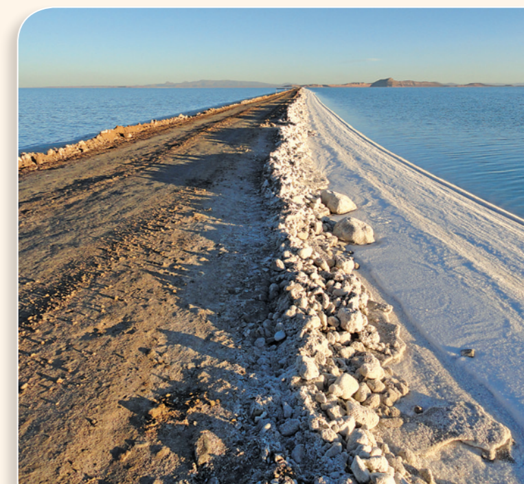
Terraplén de acceso al Salar de Uyuni
