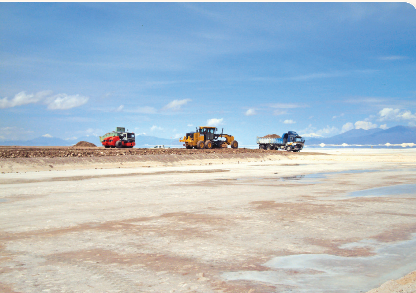
Equipo pesado en trabajos de construcción de piscinas de evaporación
