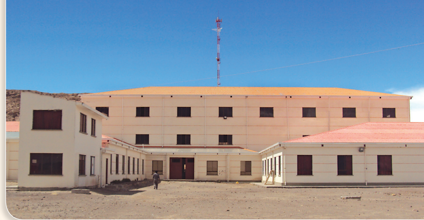
Vista parcial de la infraestructura de la Planta de Li 2 CO 3
