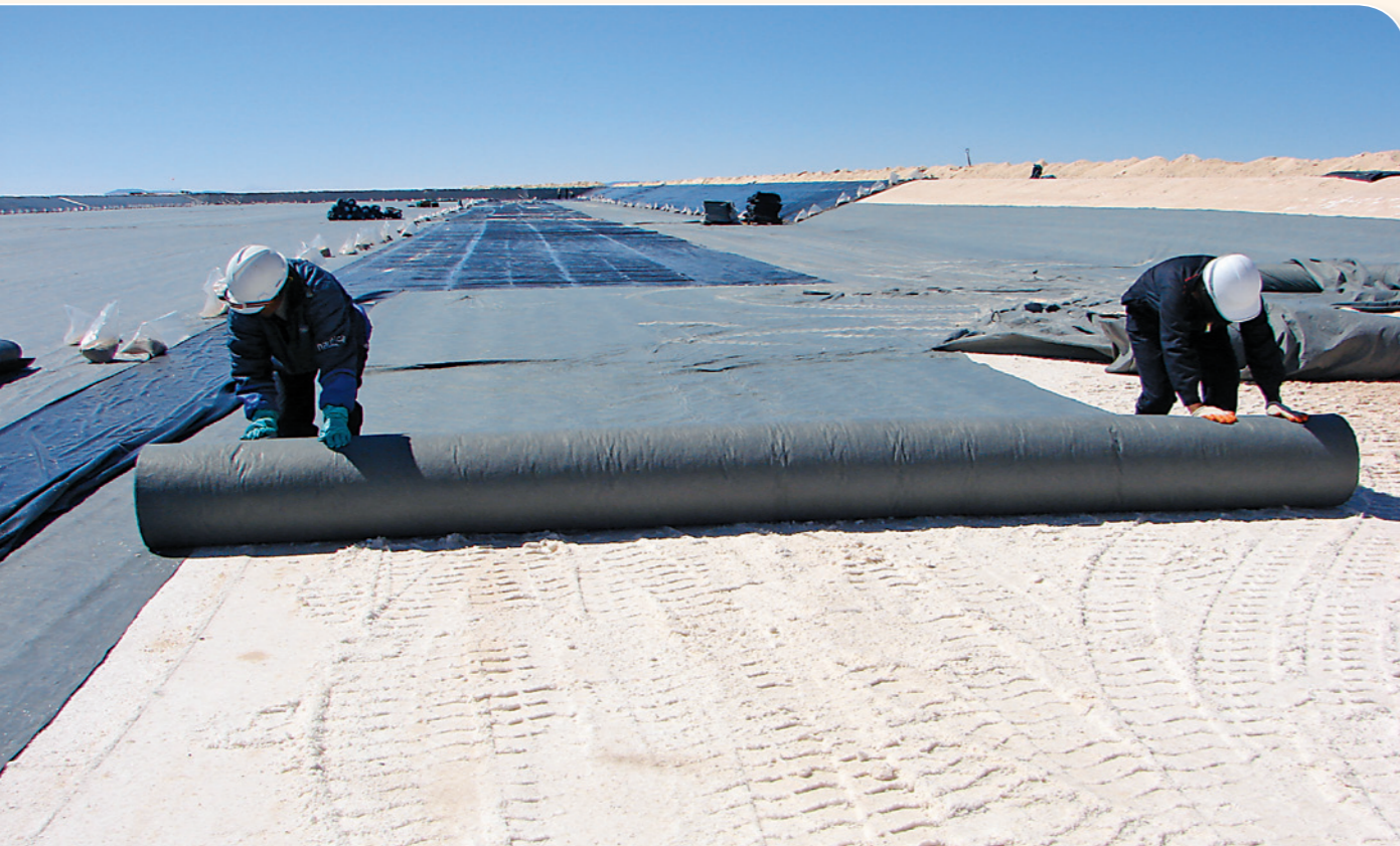
Trabajos de impermeabilización de piscinas de evaporación
