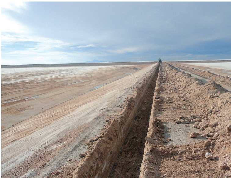
Cavado de zanja para el anclaje de geomembranas, última etapa en la construcción de una de las piscinas de evaporación industrial
