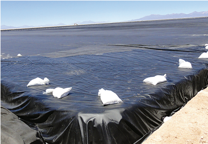
Piscina de evaporación industrial impermeabilizada
