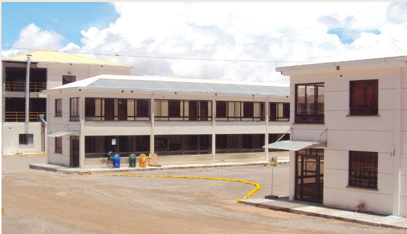
Infraestructura de la GNRE en Llapi
