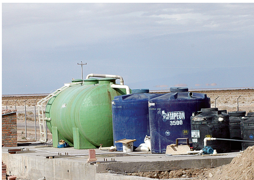
Planta de tratamiento de aguas residuales instalada en Llipi
