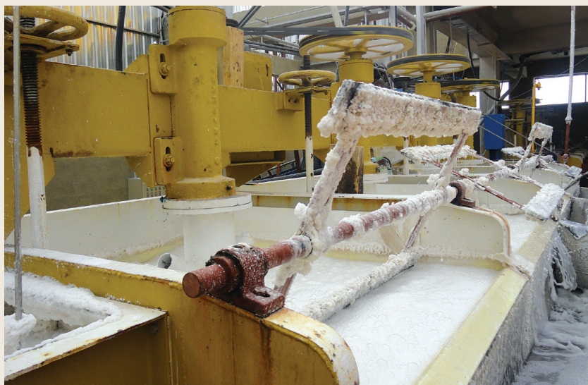
Celdas de flotación en Planta KCl
