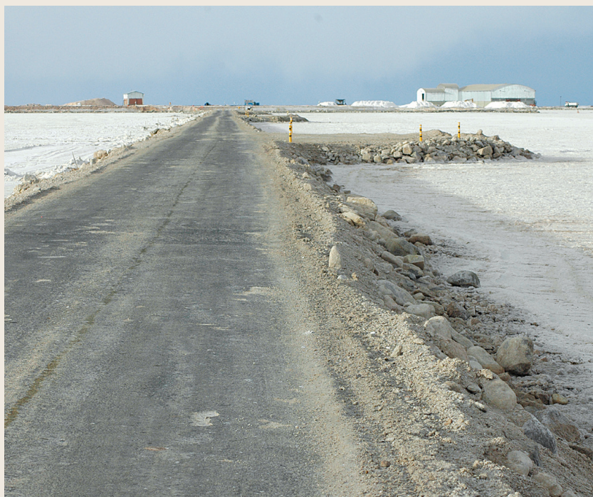
Terraplén de acceso a instalaciones del salar, al fondo la Planta semiindustrial de KCI
