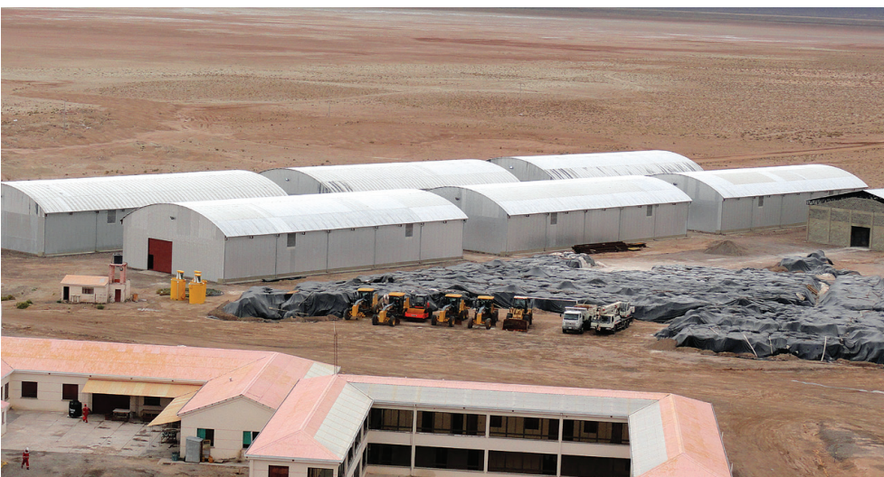
Galpones de almacenamiento
