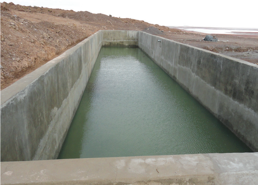
Estanque de agua potable construida en la cima del cerro Llipi
