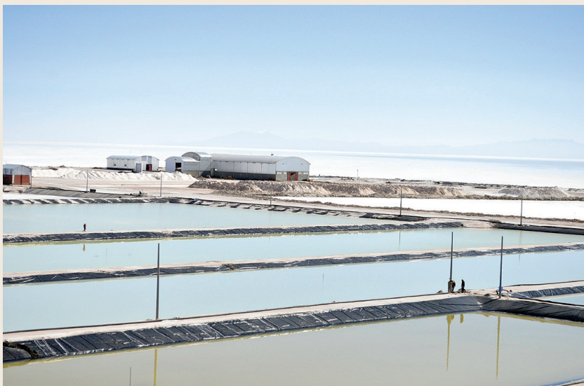
Parte del circuito de piscinas de evaporación de la Fase Piloto
