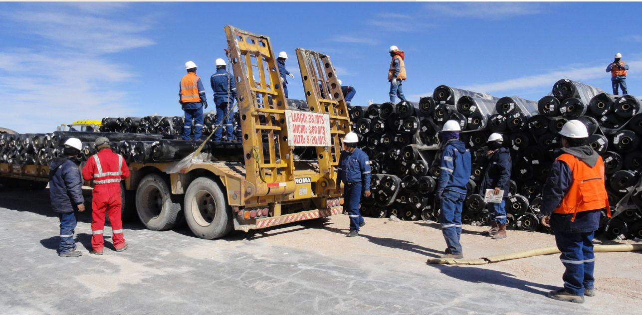
Disposición de geomembranas para la impermeabilización de piscinas de evaporación
