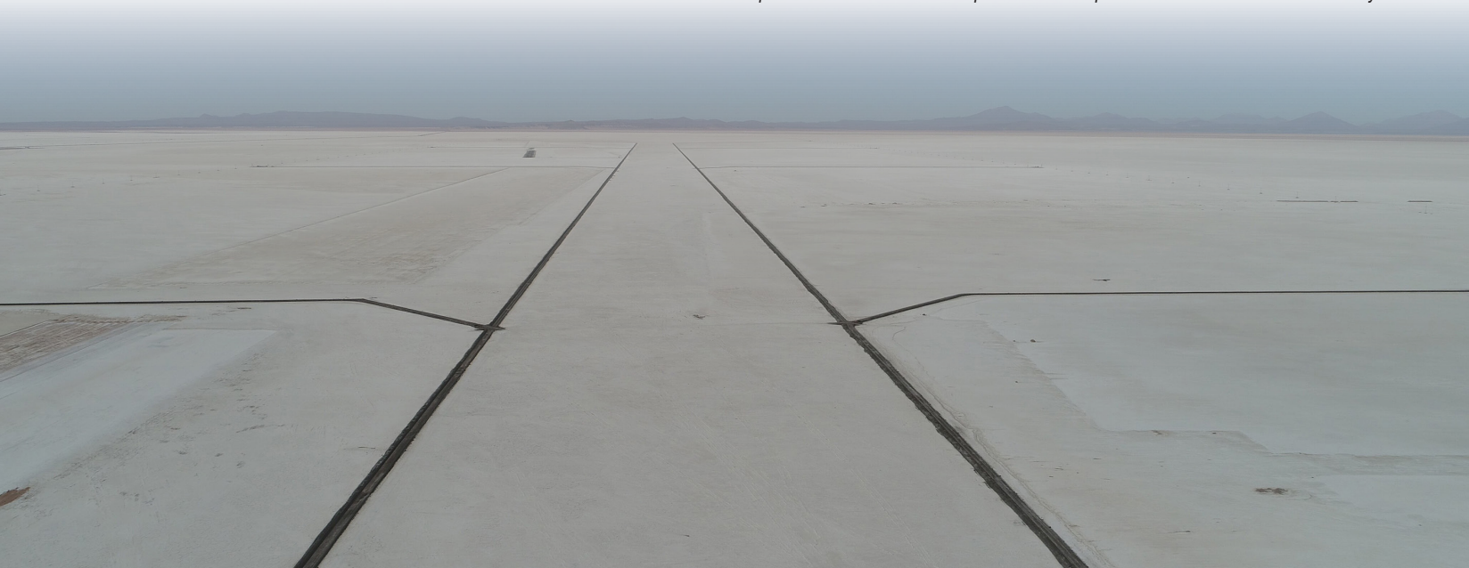
Red de bombeo que alimenta de salmuera a piscinas de evaporación industrial en el Salar de Uyuni
