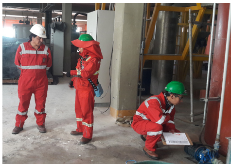
Inspecciones realizadas por los técnicos en seguridad industrial en Planta Piloto de Carbonato de Litio
