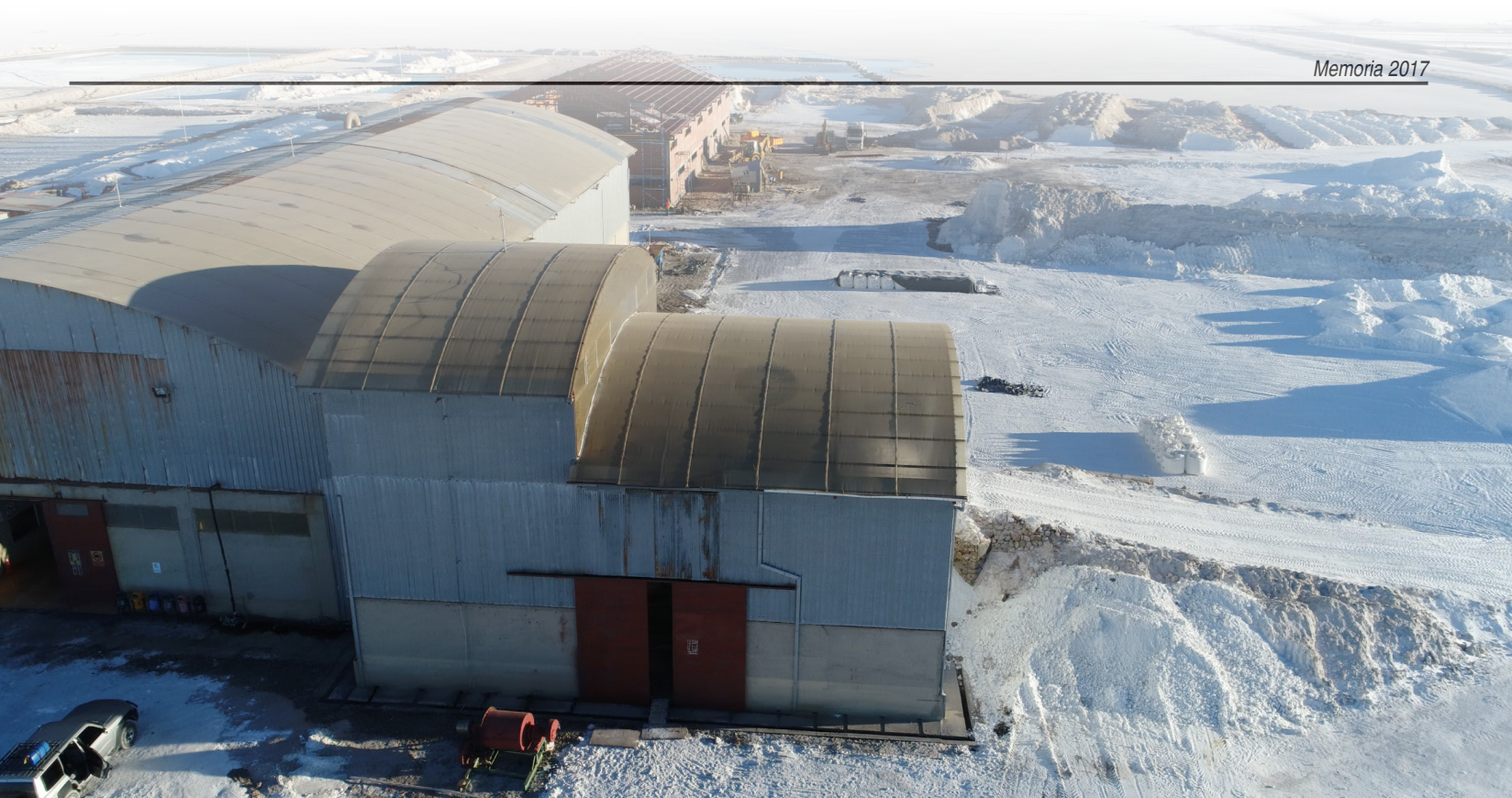
Vista externa de Planta Piloto de Cloruro de Potasio
