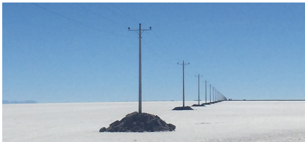
Instalación de red eléctrica de media tensión para las estaciones de pozos de bombeo
