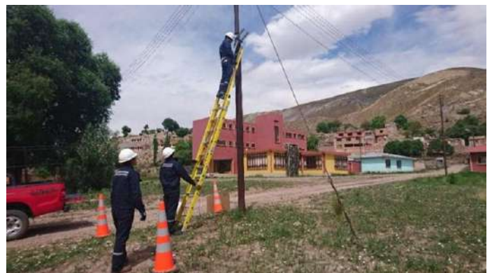
Montaje de Sistema Fotovoltaico para iluminación de exterior
