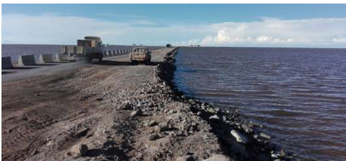
CONFORMACIÓN DE CAPA SUB BASE
