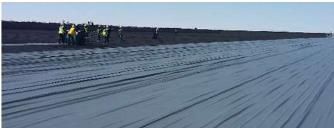
INSTALACIÓN DE GEOMEMBRANA PVC DE 0,75 MM.
