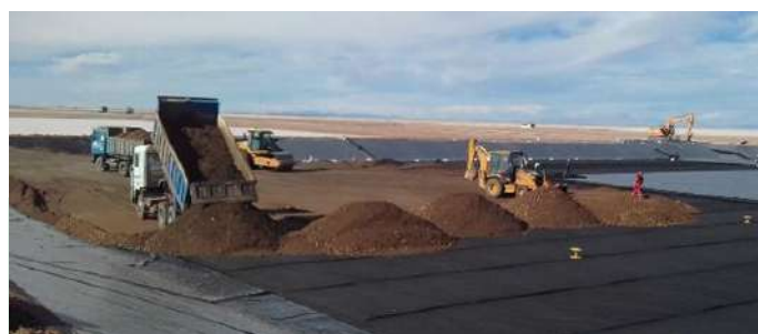
Conformación de piso cover
