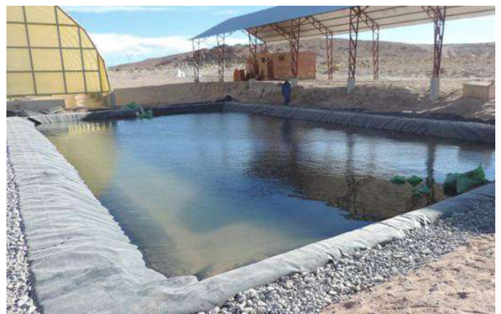
Piscina de acumulación de aguas domésticas tratadas
