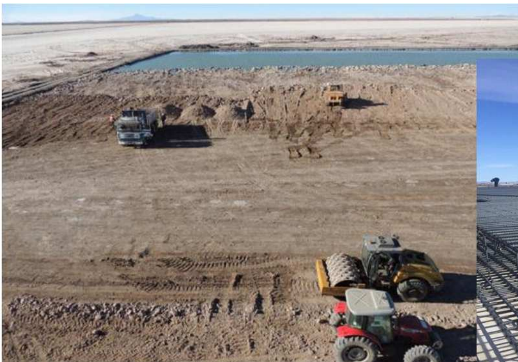
OBRAS DE CONFORMACIÓN Y ENFERRADURA DE PLATAFORMA PLANTA INDUSTRIAL
