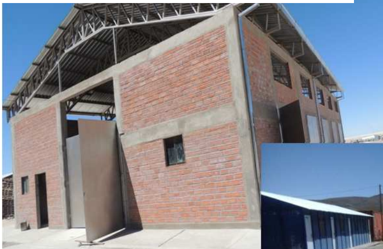
GALPÓN DE ACOPIO DE RR.SS. - LLIPI
