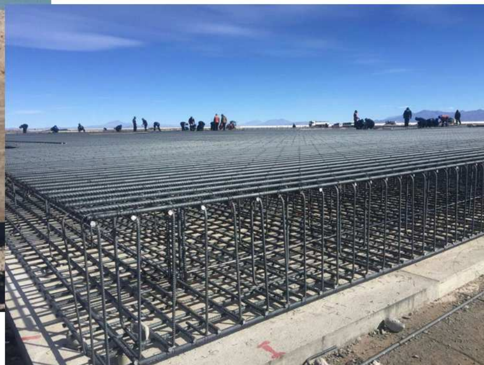
OBRAS DE CONFORMACIÓN Y ENFERRADURA DE PLATAFORMA PLANTA INDUSTRIAL
